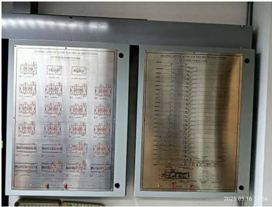
รูปที่ 3-52 แผงควบคุม (Fire Alarm Control Panel : FCP)
