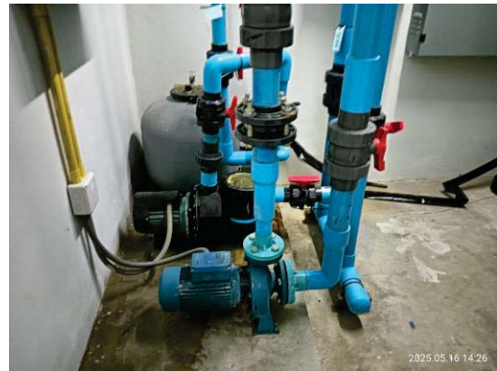
รูปที่ 3-18 ระบบสูบน้ำภายในห้องระบบบำบัดน้ำเสีย
