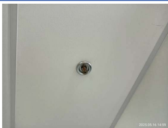
รูปที่ 3-50 ระบบหัวกระจายน้ำดับเพลิง
