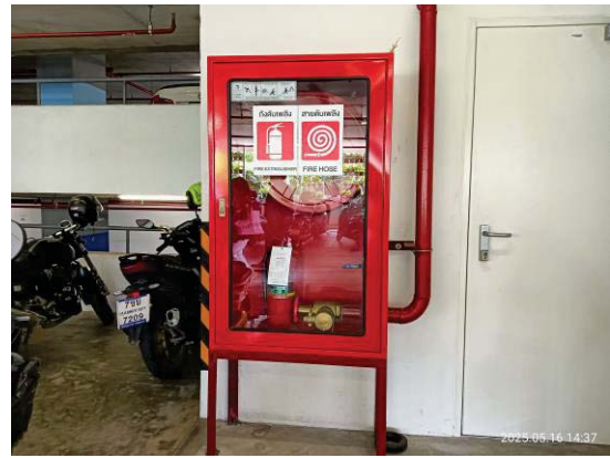
รูปที่ 3-47 ตู้เก็บสายฉีดน้ำดับเพลิงพร้อมอุปกรณ์
