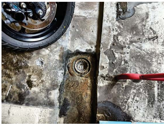
รูปที่ 3-68 ตะแกรงปิดรูท่อระบายน้ำ
