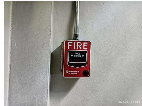
รูปที่ 3-55 เครื่องแจ้งเหตุโดยใช่มือดึง (Manual Station)
