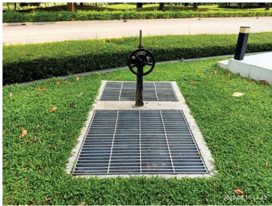
รูปที่ 3-26 ระบบบ่อน้ำภายในโครงการและบริเวณบ่อดักขยะและบ่อดักตรวจคุณภาพน้ำ
