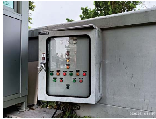
รูปที่ 3-27 ตู้ควบคุมเครื่องสูบน้ำ
