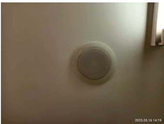
รูปที่ 3-56 ลำโพงแจ้งสัญญาณเตือนอัคคีภัย (Alarm Horn With Strobe Light)
