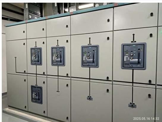
รูปที่ 3-35 ระบบมิเตอร์ไฟฟ้าส่วนกลาง
